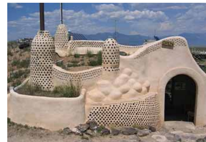
Obr. 12 Michael Reynolds: Samodržitelný dům „earthship“, Florida, USA, 2008
