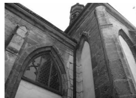
Detail řešení nároží. Kružba v okně je až z 19. století.
