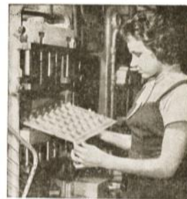
Obr. 62. Ťahanie fólie z PVC na kalandri
