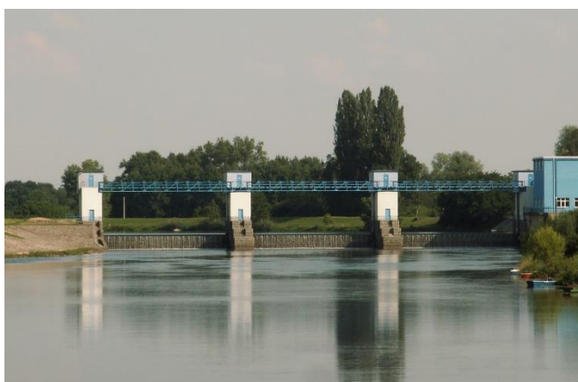
jez / vodní elektrárna
